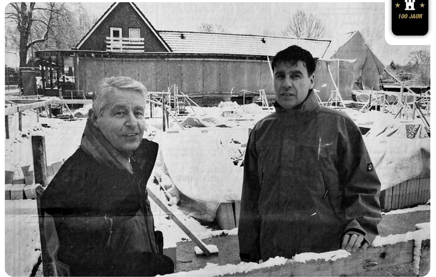
Jaap en Jan bij de bouwplaats van de zaak | Foto: Henk Benting
